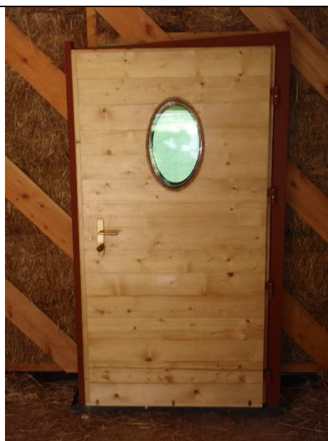
EN COURS DE MONTAGE
